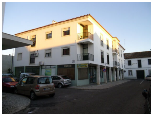
Figura 2 - Edifício de habitação multifamiliar, de construção recente, no interior da ARU
