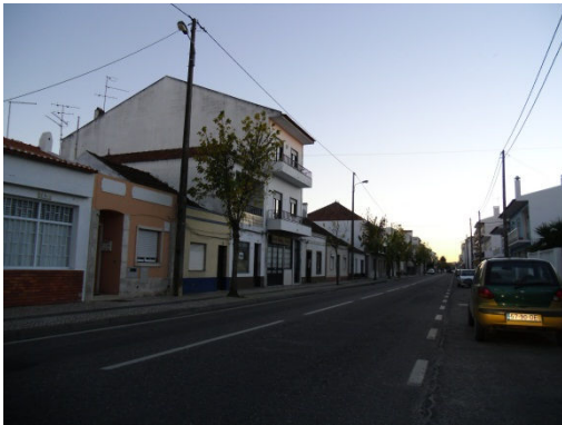
Figura 7 - Vista sobre a Rua de Alpiarça. O eixo viário que atravessa a cidade de Almeirim
