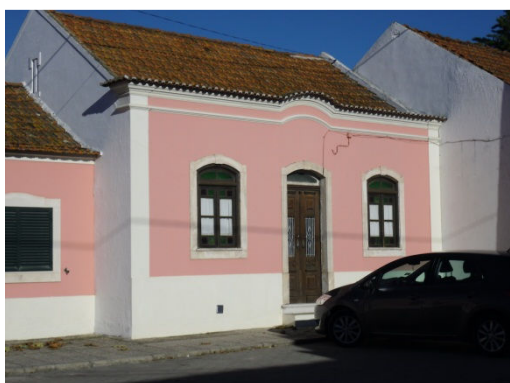
Figura 4 – Edifício em bom estado de conservação, de características tipológicas a preservar
