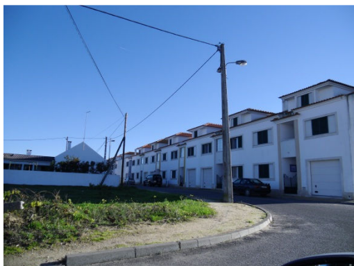
Figura 8 – Edifícios habitacionais, de construção recente no interior da ARU
