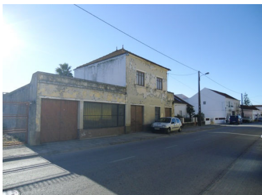
Figura 6 – Exemplo de edifício em mau estado de conservação
