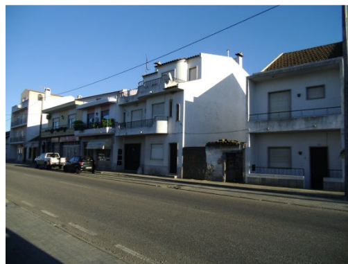
Figura 5 – Edifícios em ruína integrados na malha urbana. Rua Direita
